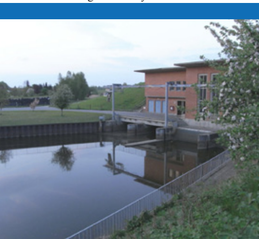
Pumping station at Weser dyke (© Nationalpark- und BR-Verwaltung Niedersächsisches Wattenmeer)
