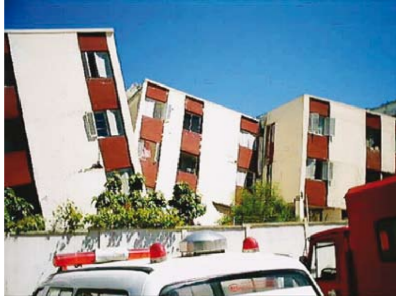
شكل 6.2. ميلان مبان سكنية على بعضها البعض في مدينة بومرداس (شرق الجزائر العاصمة) بفعل اهتزاز الأرض المرافق للزلازل الذي وقع بتاريخ 21/5/2003. [مصدر الصورة: اللعومي، 2003].
