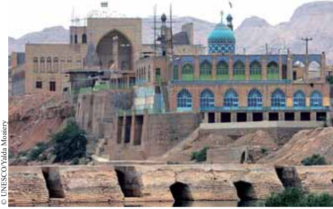
سد (بند - ي - ميزان) في مدينة شوشتر في إقليم «خوزستان». فالنظام الهيدروليكي التاريخي في شوشتر في إيران، يمكن اقتفاء أثره حتى عهد داريوس الكبير في القرن الخامس قبل الميلاد. وكان يقضي بإيجاد قناتين تحويليتين رئيسيتين على نهر «كارون» إحداهما قناة «غرغار»، لا تزال تغذي مدينة شوشتر بالمياه حتى اليوم، عبر سلسلة من الأنفاق التي تزود مطاحن بالماء.
