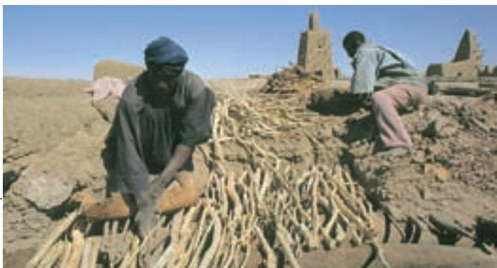
Restauration du toit de la mosquée Djingarey Ber à Tombouctou, site du patrimoine mondial depuis 1988. Ces hommes posent des branches par dessus les poutres en bois de palmier avant de recouvrir le tout de boue. C'est l'une des trois mosquées restaurées en 2003 dans le cadre d'un projet exécuté par la Mission culturelle de Tombouctou et la population de cette ville, avec le soutien de CRATerre-EAG et un financement du Centre du patrimoine mondial de l'UNESCO. Depuis janvier, les autorités maliennes préparent un plan de gestion et de préservation pour Tombouctou qu'elles ont l'intention de soumettre cette année au Comité du patrimoine mondial. En mars, la municipalité a nommé un comité de gestion composé des imams des trois mosquées, de représentants de toutes les localités, de guides touristiques et d'autorités municipales et administratives
