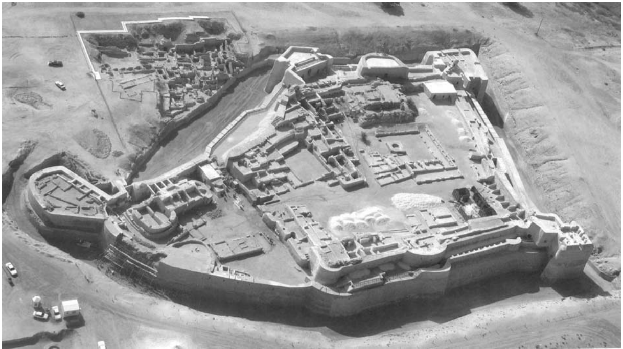
Vue aérienne vers le sud du Fort de Bahrain
