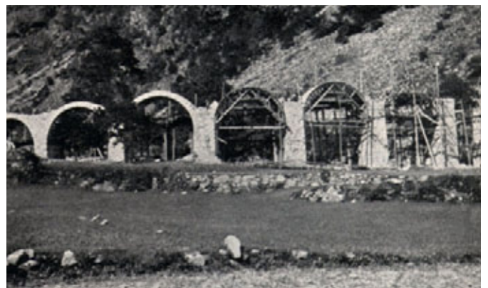
Circular Viaduct at Brusio > Arch masonry 1907. Photograph taken from: E. BOSSHARD: Die Berninabahn , Zurich 1912 ( Schweizerische Bauzeitung , offprint).
