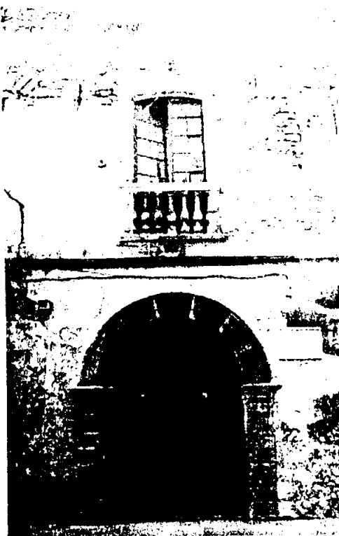
Vue sur l'entrée de l'ancien consulat du Danemark
