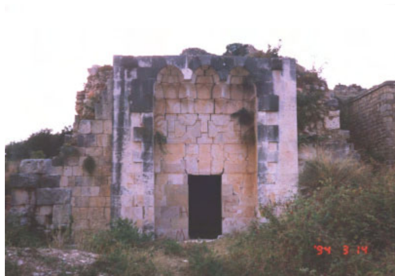
Palais Ayyubide, porche d'entrée restauré par Ecochard, photo AKTC.
