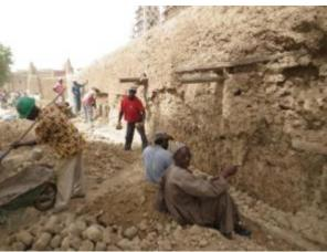
Briques traditionnelles dites Dienné Ferey, fabrication puis mise en œuvre (mur d'enceinte)
