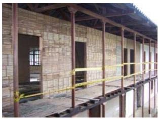
Construction d'un mur en bahareque avec des nattes de bambou et des enduits en terre, de chaux et du crottin de cheval
