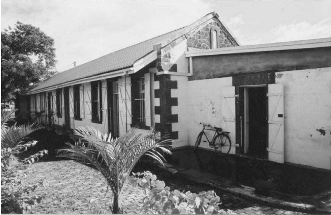
Bâtiments de l'hôpital
