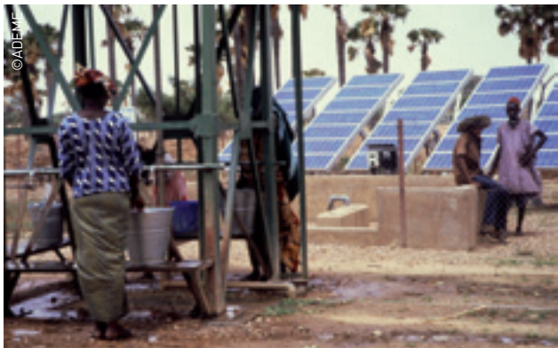
Application du solaire au pompage d'eau
