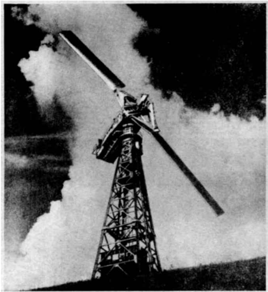
C'est sur les collines du Vermont, aux U.S.A., que se trouve la plus grande centrale expérimentale d'énergie éolienne « in the world ». Ses ailes décrivent un cercle dont le diamètre mesure plus de 55 mètres. Photo « Discovery ».
