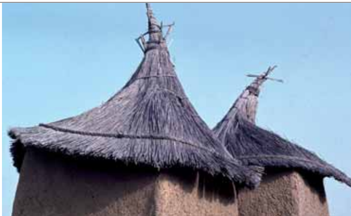
① 马里杜罗村的本土建筑
