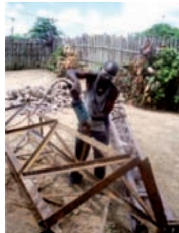
Un ouvrier travaillant au montage du pylône destiné à supporter l'antenne d'une des radios du Congo
