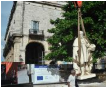
© UNESCO La Habana. Estatua del Rey Fernando VII es removida temporalmente de la zona exterior del Palacio para dar paso a los trabajos de restauración.
