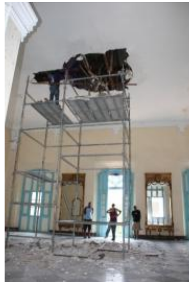
© UNESCO La Habana. Momento en que se comienza a destruir el falso techo que ocultó la cúpula del Palacio durante décadas.
