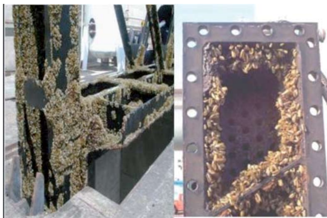
Figura 3. Estructuras hidráulicas colonizadas por Limnoperla fortunei en los Embalses del Río Negro.
