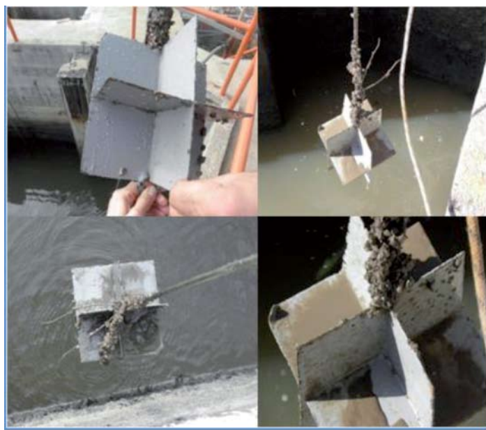
Figura10. Paneles de incrustación en la pileta de captación de agua para el sistema de refrigeración de la refinería La Teja. Izquierda: junio 2010, derecha, julio 2010. Ausencia de macrofouling sobre estructuras pintadas con Hempasil 77500.
