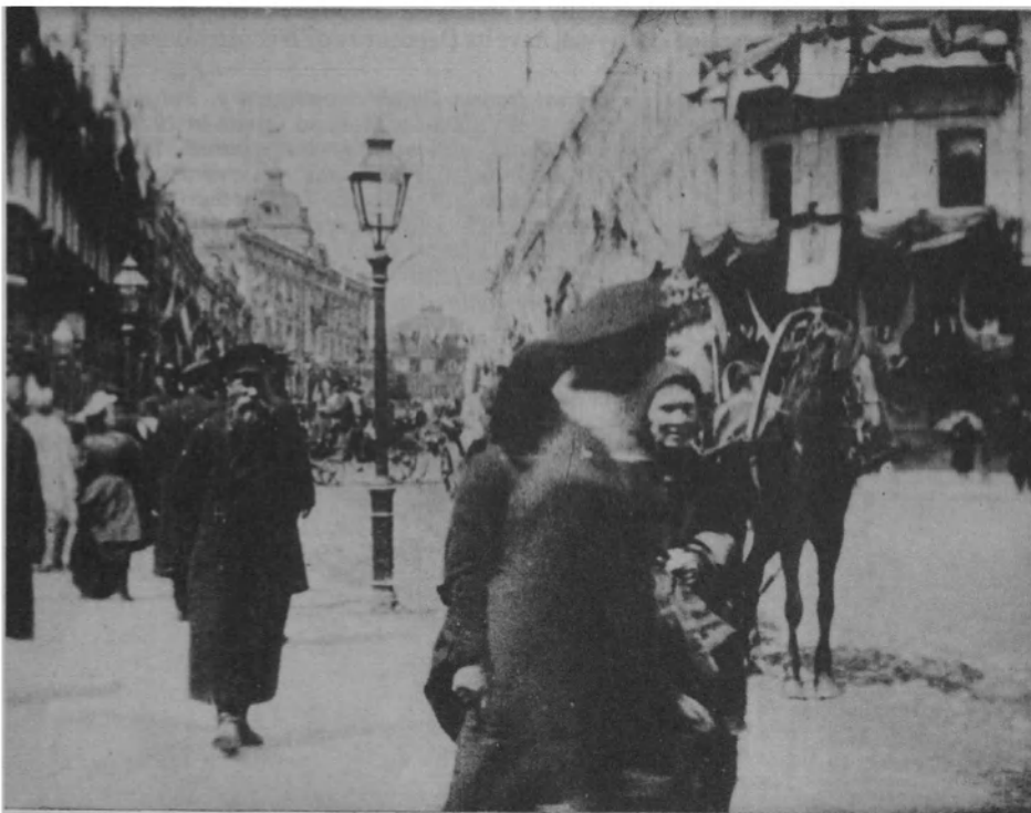
Photo © Centre National de la Cinématographie, Bois-d'Arcy, France
