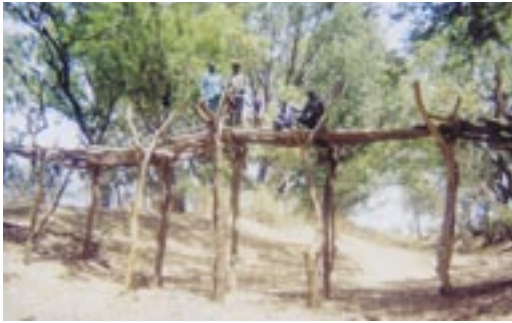
Puente de madera construido para dar acceso durante las crecidas a zonas protegidas
