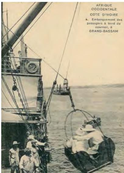
Photographie n°23 : embarquement des passagers à bord d'un panier sorte de nacelle fixée à un treuil
