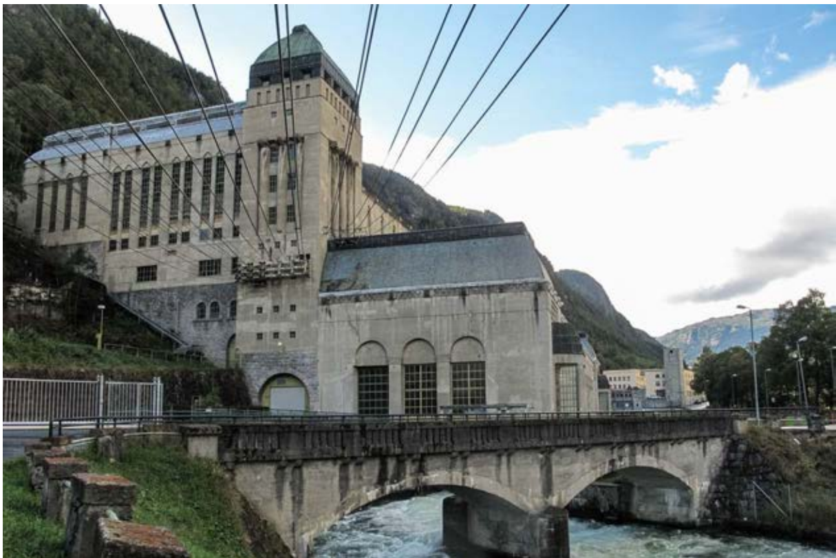
Centrale électrique Sâheim
