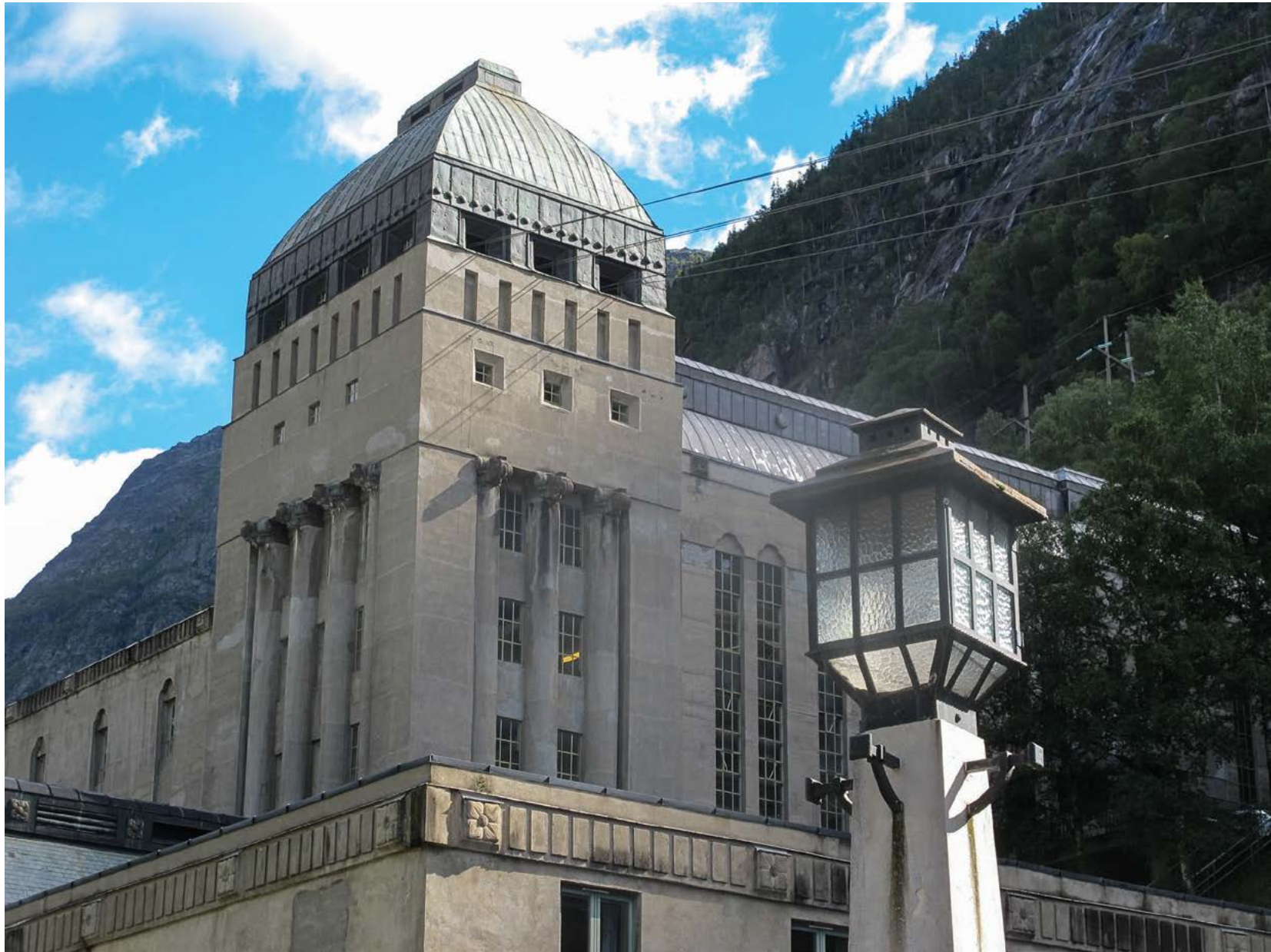
Fig. 32 Såheim Power Plant. Photo: Trond Taugbøl
