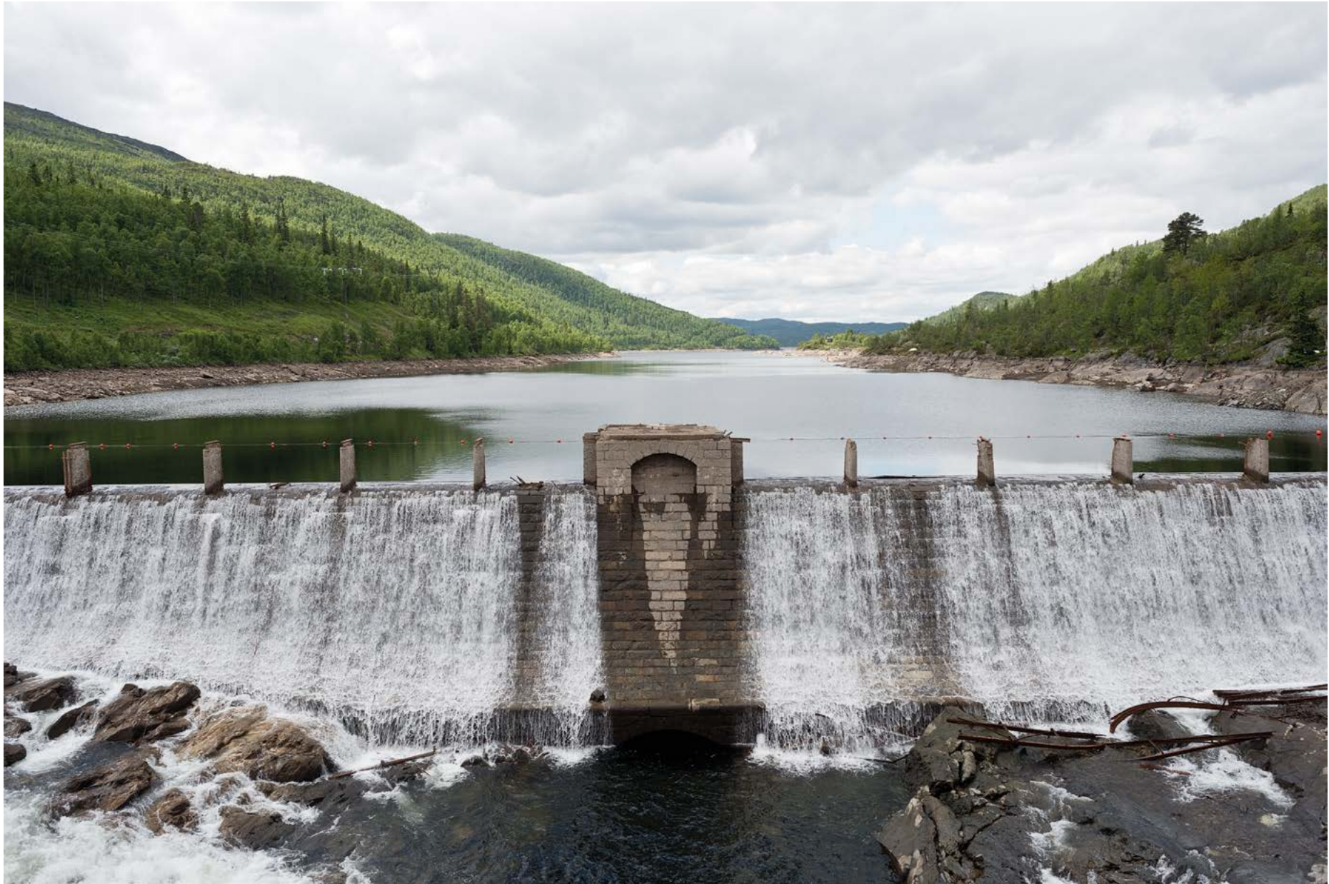
Fig. 17 Skarsfos Dam I. Photo: Per Berntsen
