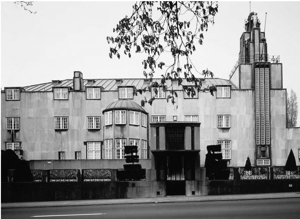
Vue d'ensemble de la façade sur rue
