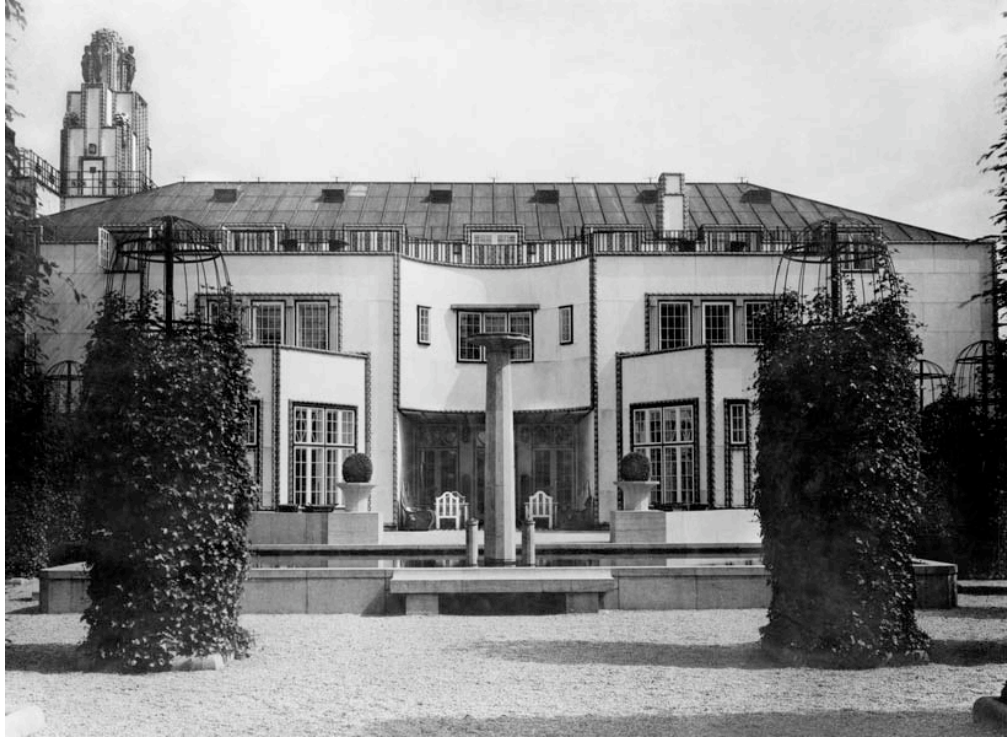
Façade vers le jardin
