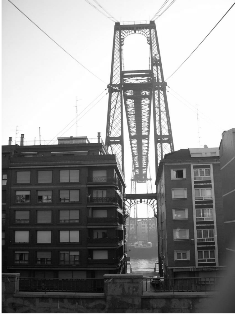
Pont depuis la rue
