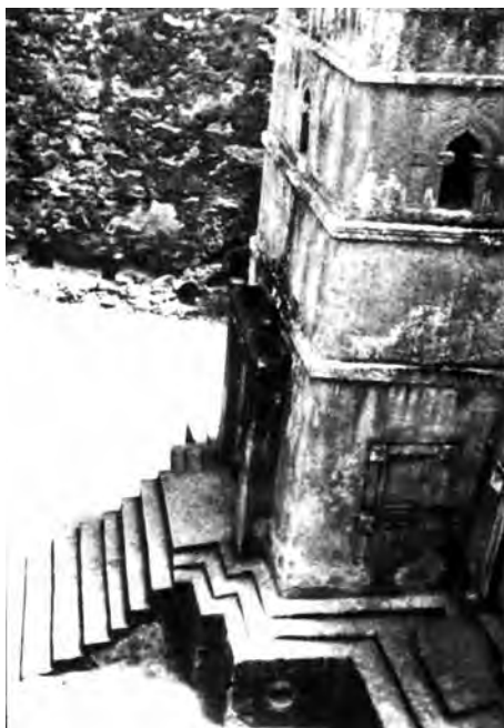
FIGURA 17.4 Lalibela: elevação vertical da igreja (“casa”) de São Jorge. (Foto E. Haberland, Instituto Frobenius.)
