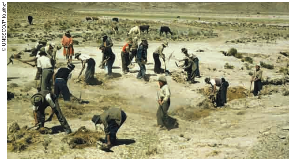
Construction d'une route sur les hauts plateaux boliviens.
