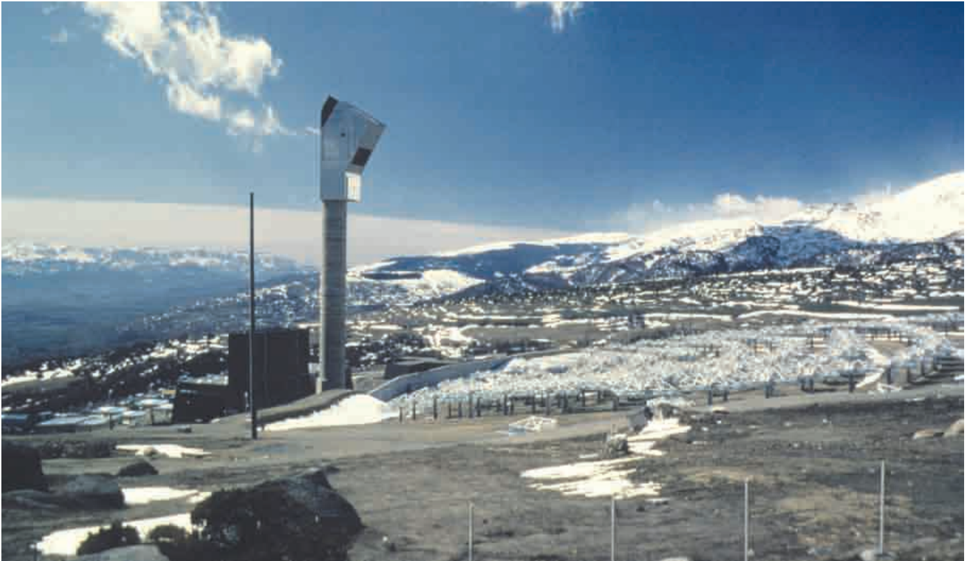
Centrale solaire Themis (France).
