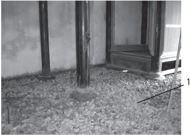
Figure 6-21a: Interior floor repair / Tu sửa nền nhà bên trong
