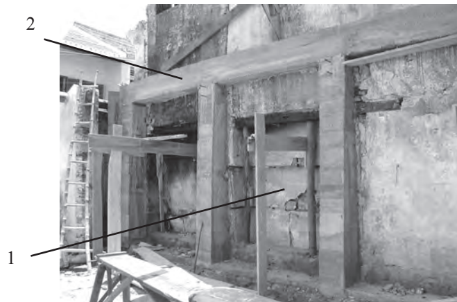
Figure 6-18b: Repair work to fix leaning walls / Việc tu sửa phần tường bị nghiêng
