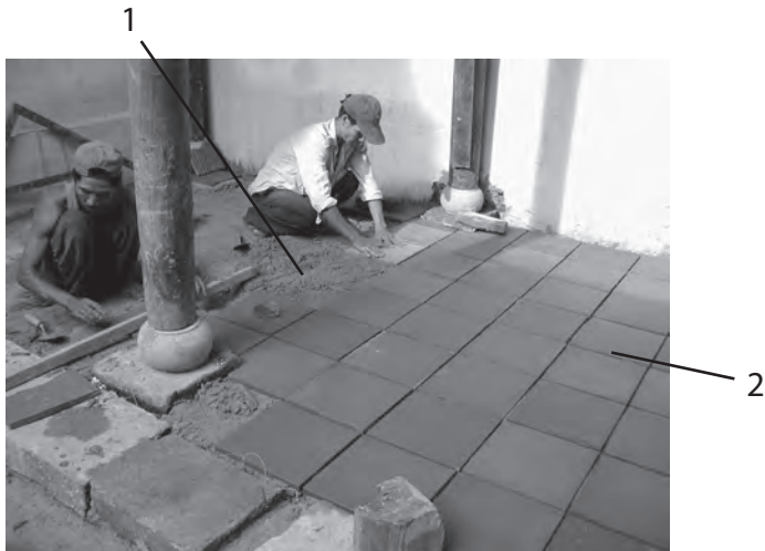
Figure 6-21b: Interior floor repair / Tu sửa nền nhà bên trong
