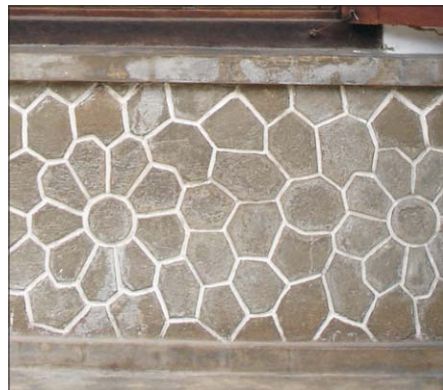
Fig. 153: Natural stone layer on wall Gbr. 153: Batu alami pada dinding
