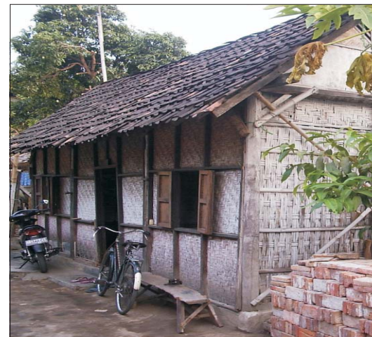
d. Panggang pe roof type d. Tipe atap panggang pe
