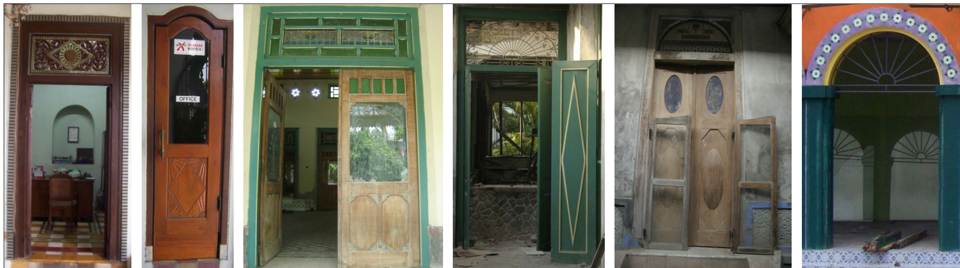
Fig. 95: Various door types of Kalang house Gbr. 95: Berbagai tipe pintu pada rumah Kalang
