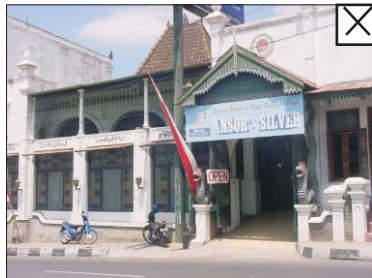
Fig. 144: Enclosing the pendapa leads to high room temperature and bad lighting Gbr. 144: Pendapa yang tertutup membuat udara panas dan agak gelap
