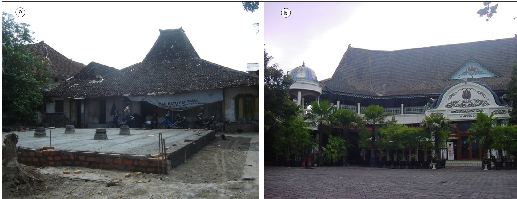
Fig. 112: Adaptive re-use of a house to be (a) the office of the Center for Heritage Movement, Universitas Gadjah Mada (Javanese traditional house) and (b) a restaurant and hotel (Kalang house) Gbr. 112: Perubahan fungsi dari rumah menjadi (a) kantor Pusat Gerakan Pusaka, Universitas Gadjah Mada (rumah tradisional Jawa) dan (b) restoran dan hotel (rumah Kalang)
