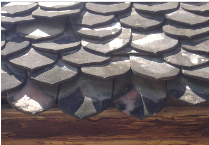
Fig. 119: Shingle clay roof tiles in the dalem Gbr. 119: Genteng tanah liat berbentuk sirap pada dalem
