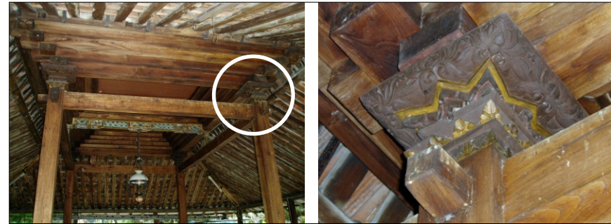
Pendapa roof structure with mayangkara Struktur kayu pendapa dengan mayangkara
