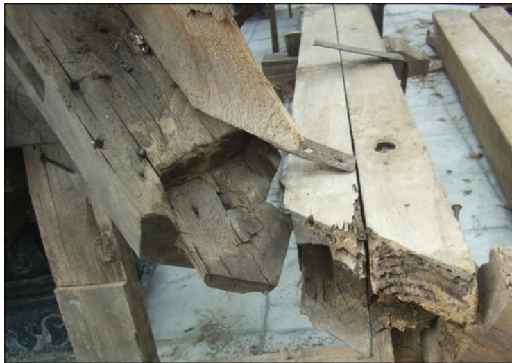
Fig. 79: Detail D7, joint between dudur brunjung and takir Gbr. 79: Detil D7, sambungan antara dudur brunjung dengan takir
