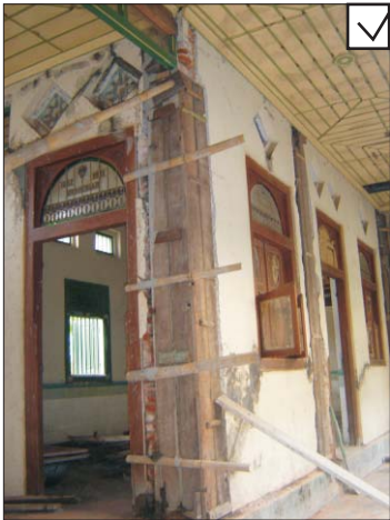
Fig. 143: Concrete column replacement Gbr. 143: Penggantian dengan kolom beton
