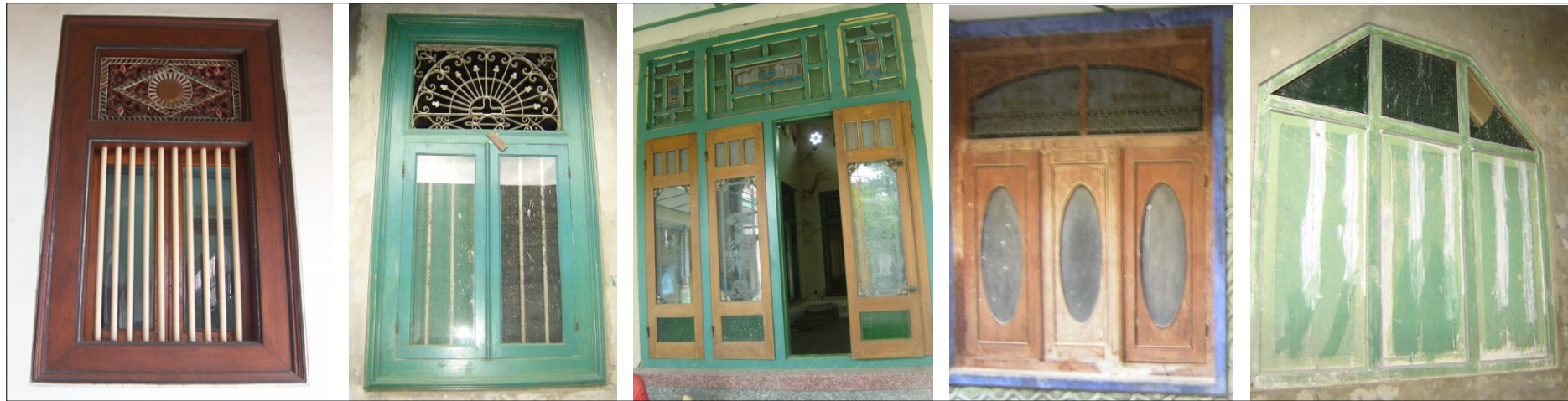
Fig. 94: Various window types of Kalang house Gbr. 94: Berbagai tipe jendela pada rumah Kalang
