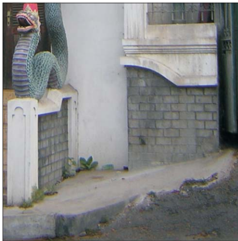
Fig. 86: Stone pattern of Kalang house foundation Gbr. 86: Motif batu pada pondasi rumah Kalang
