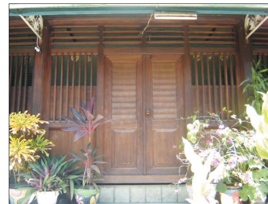
Fig. 118: Gebyoks installed as walls of the dalem Gbr. 118: Gebyok-gebyok dipasang sebagai dinding dalem
