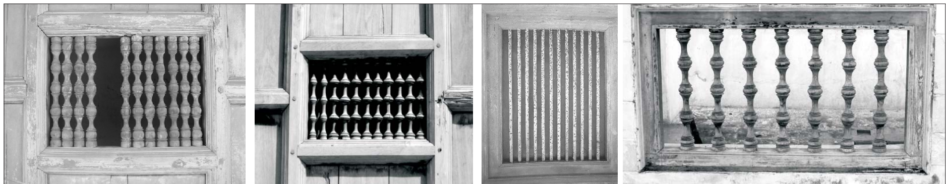
Fig. 57: Various wooden bars models for ventilation openings of doors and windows Gbr. 57: Berbagai model jeruji kayu untuk ventilasi pintu dan jendela
