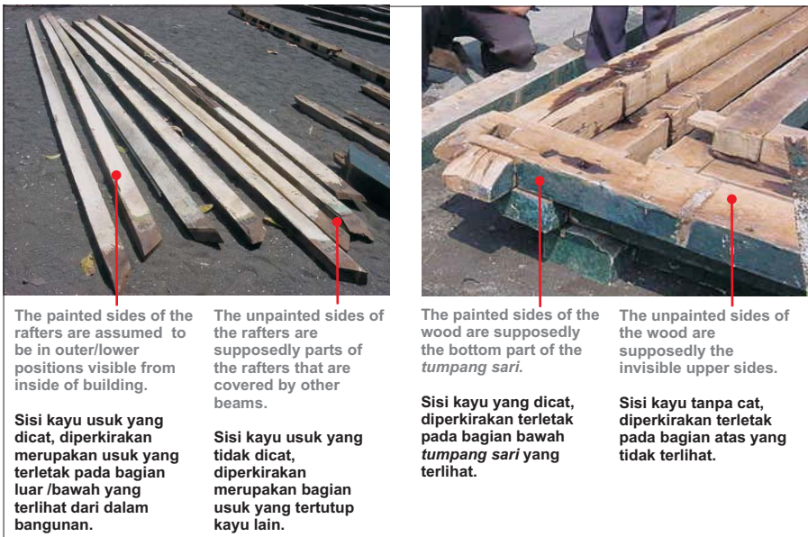
Fig. 165: Polished or painted wood can be a hint that it was installed in a position normally visible Gbr. 165: Bagian kayu yang dicat/diplitur bisa menjadi petunjuk bahwa letaknya berada di luar/bagian yang terlihat
