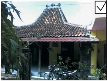
Fig. 127: Pendapa with clay roof tile Gbr. 127: Pendapa dengan atap genteng tanah liat
