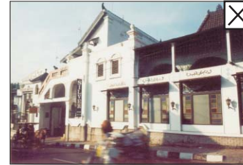
Fig. 141: Inappropriate demolition of the pendapa Gbr. 141: Penghilangan pendapa yang kurang tepat
