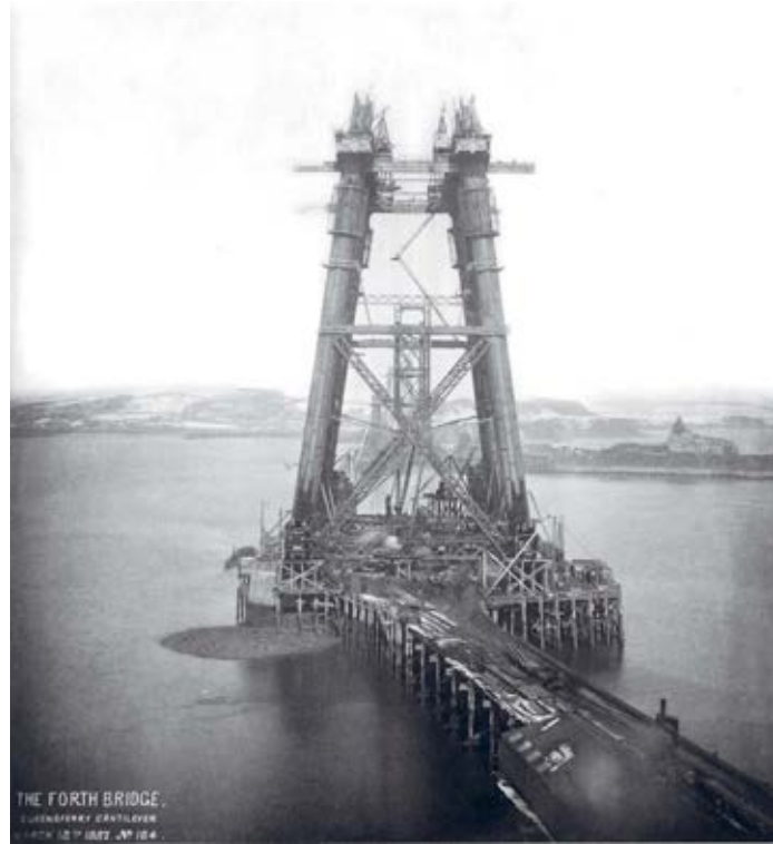
Photographie de la construction du pont (1887)
