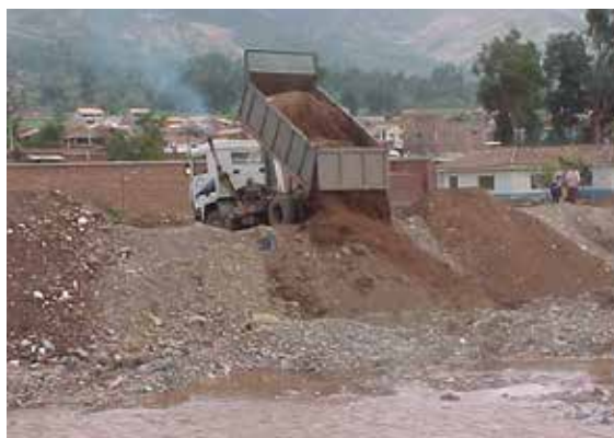
Figura 16. Descarga de desmontes en el Huatanay (San Juan de Dios, San Jerónimo, Cusco)
