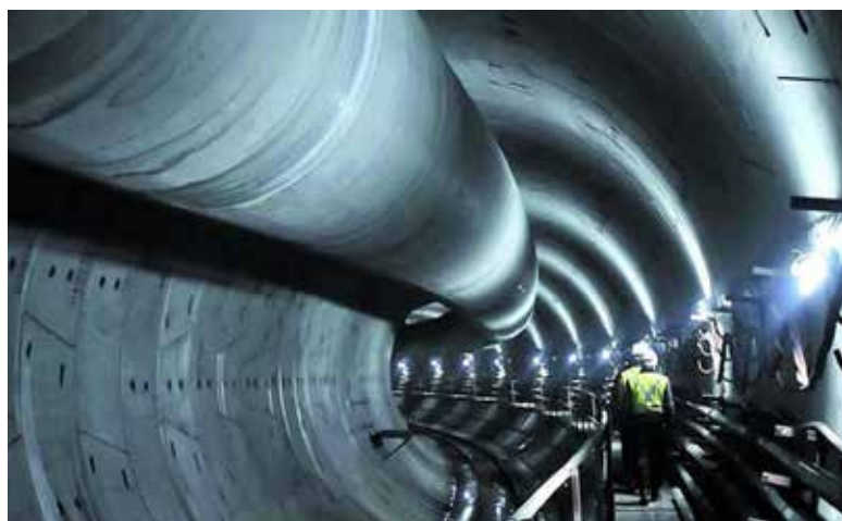
Figura 18. Construcción de túneles aliviadores en la ciudad de Buenos Aires
