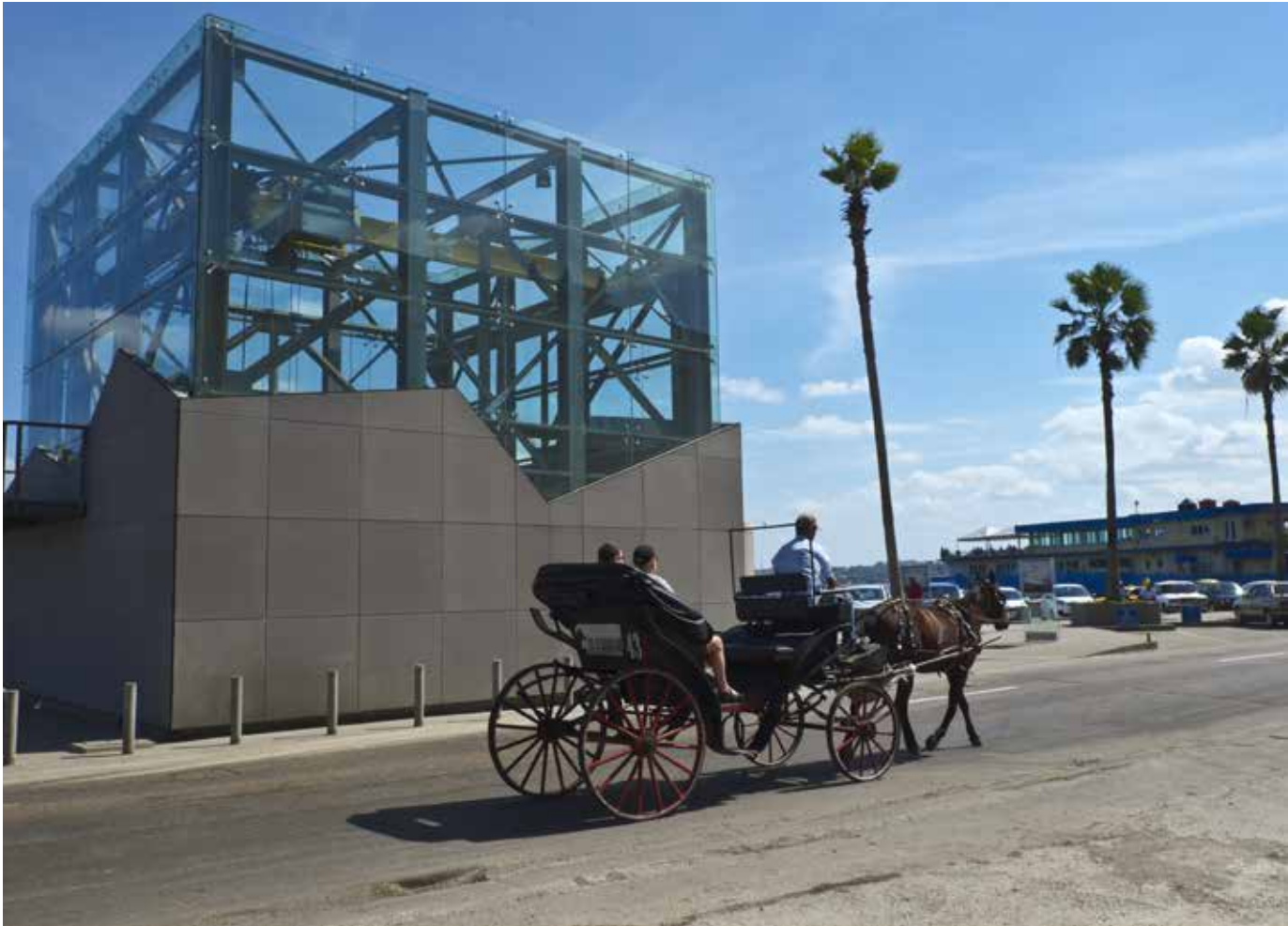
Formando parte de las obras que se realizan en el casco histórico de La Habana, capital de Cuba, e insertada en la armonía de centenarias y modernas construcciones, se encuentra ésta que masks la cámara de rejas subterránea, destinada a evitar la entrada de objetos y arenas al sifón que a través de un túnel atraviesa la bahía, de un lado a otro, y, mediante bombas, entrega los drains del sewer de la ciudad en el lugar donde se realiza su disposición final. Fuente: Juan de las Cuevas y colaboradores. Publicación de la Oficina del Historiador de la Ciudad de La Habana, Cuba, año 2012, pág. 38-56 Fotografía: Cortesía de Lissette Solorzano
