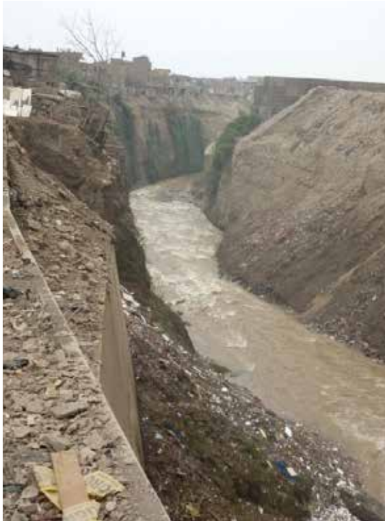
Figura 12. Cañón urbano formado por la degradación del cauce del Río Rímac aguas abajo del Puente del Ejército
