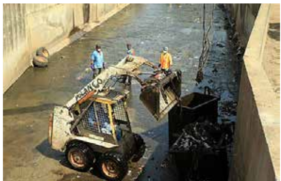
Figura 2.10b Obras de limpieza de cauces ejecutadas por la Alcaldía de Managua
