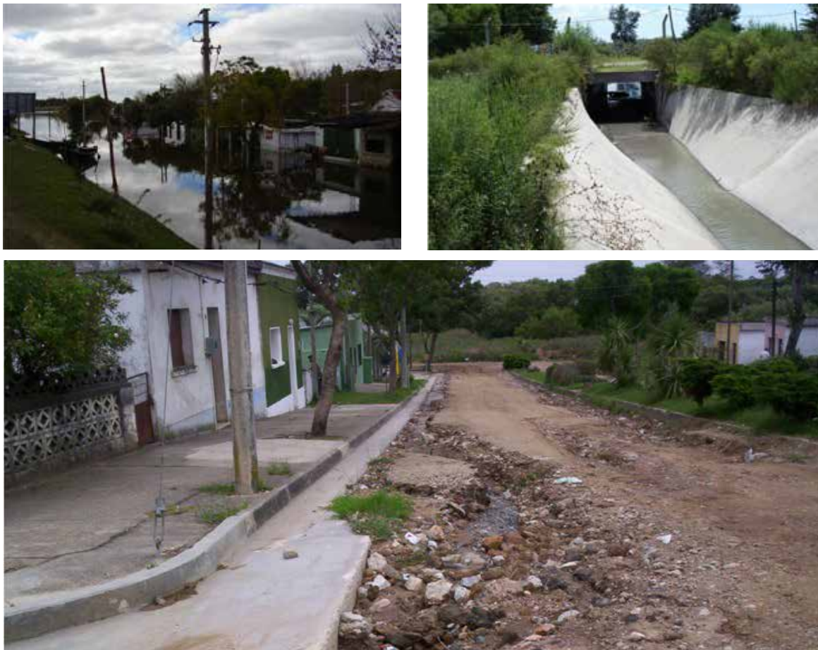
Figura 5. Problemas de drenaje pluvial en ciudades del país.
