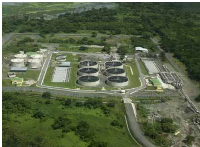
Figura 4.1 Moderna planta de tratamiento de las aguas residuales de la ciudad de Managua
