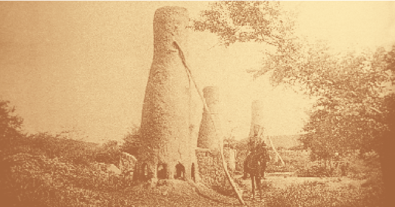
Fours métallurgiques du Yatenga avec soldat à cheval donnant l'échelle
