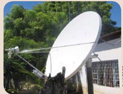
Antenne satellitaire installée à l'Institut halieutique et des sciences marines à Tuléar, Madagascar, afin de faciliter l'accès au réseau Internet à travers les stations de terrain VSAT. Le « Very Small Aperture Terminal » est une station de terrain utilisée pour communiquer des données par satellite.
