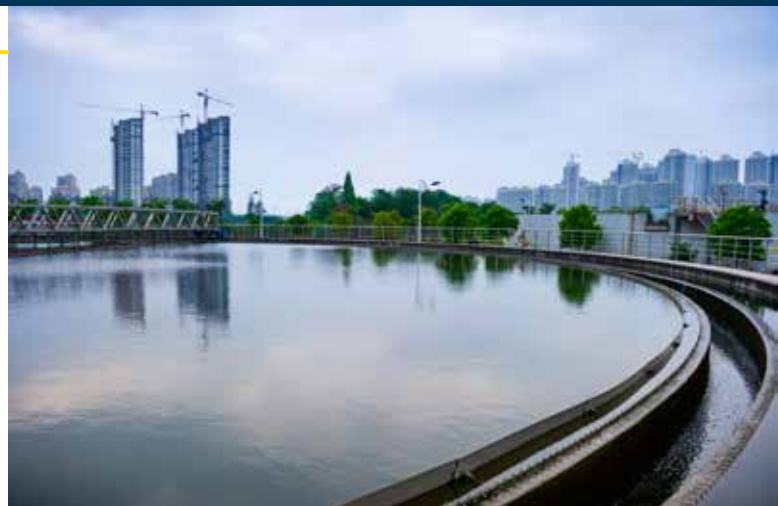
Moderna planta depuradora de aguas residuales urbanas Fotografía: © hxdyl/Shutterstock.com
