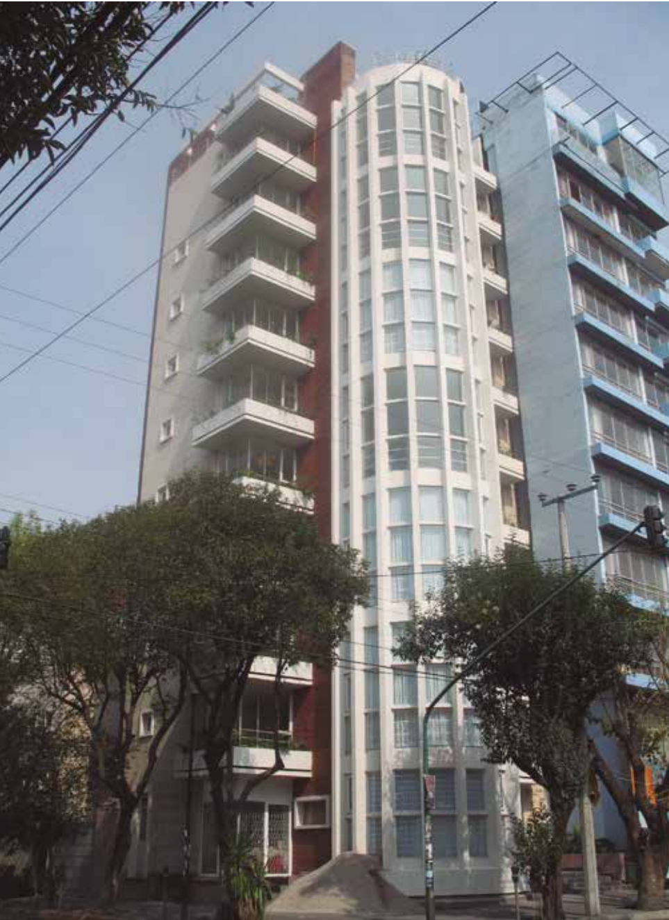
Edificio de Río Balsas, Arquitecto Mario Pani, 1943-44, México D.F. Restaurado por el Arquitecto Juan Carral. Foto Louise Noelle.
