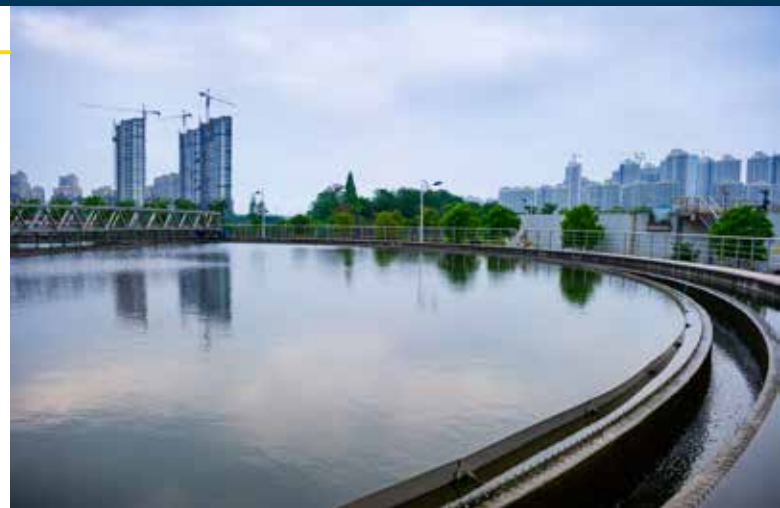
Station d'épuration moderne en milieu urbain Photo : © hxdyl/Shutterstock.com
