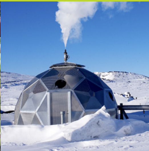
Perfuração de sondagem geotérmica (Islândia) Imagem: Lydur Skulason
