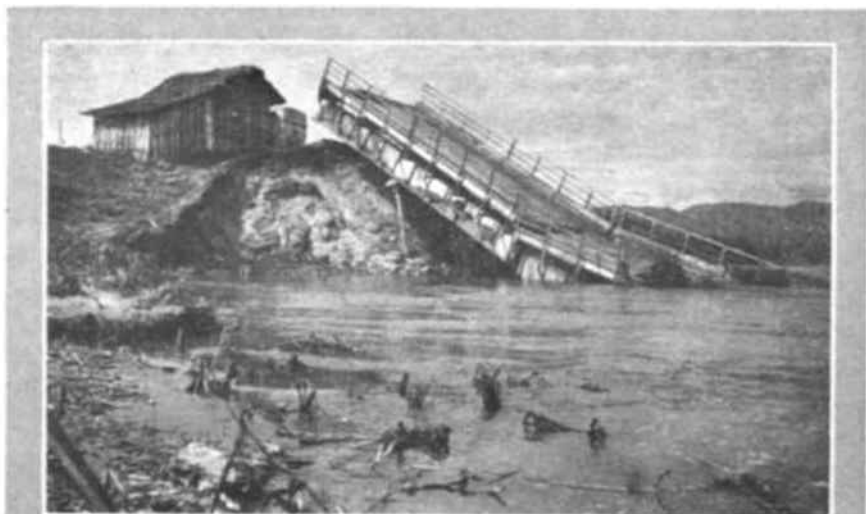
Le plus grand pont de l'Assam, celui de Ranganadi, mesurait près de 400 mètres de long. Il fut emporté par un véritable mur liquide qui dévala dans la plaine à la suite du séisme d'août dernier.
