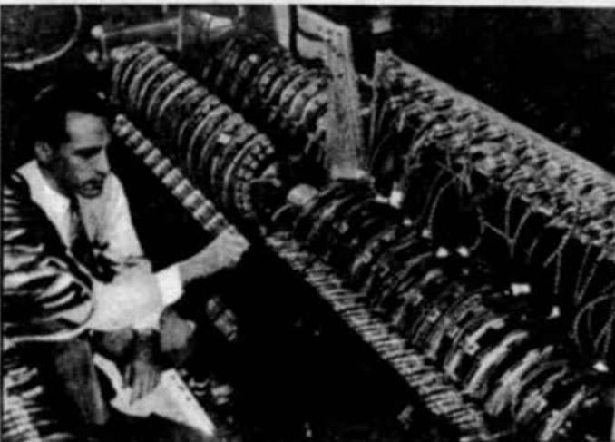
Les machines à calculer électroniques, comme la Mark III de l'Université de Harvard (ci-dessus), rappellent d'énormes postes de T.S.F. extrêmement compliqués ; elles ont une « mémoire magnétique », qui se présente sous la forme de cylindres d'aluminium en rotation très rapide. Elles peuvent réaliser des opérations qui dépassent les capacités humaines : l'une d'elles a résolu en 103 heures un problème dont un être humain aurait mis 100 ans à trouver la solution. (Photo Time Magazine.)
