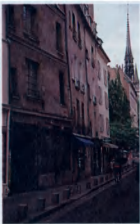
Ci-contre, travaux de démolition réalisés entre 1852 et 1855 pour le percement de la rue des Ecoles. Ci-dessous, la rue Frédéric Sauton, dans le vieux Paris. Au fond, on aperçoit la flèche de la cathédrale Notre-Dame.
