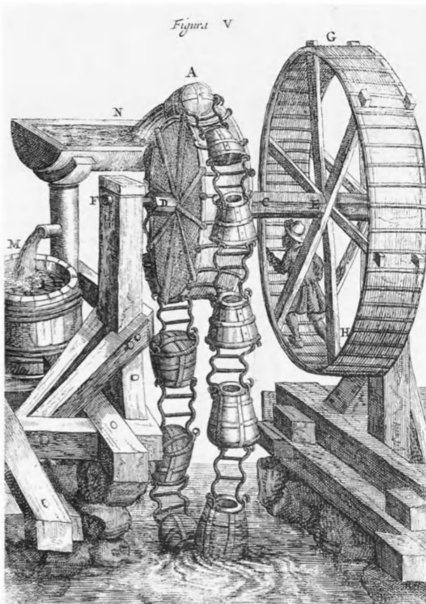
Machine hydraulique. Illustration du Mundus Subterraneus d'Athanasius Kircher, l'un des premiers grands traités de géologie, paru au 17 e siècle.
