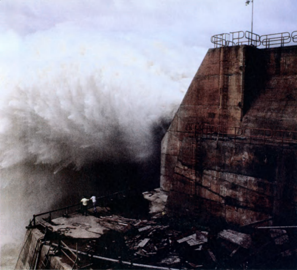
Le barrage d'Itaipu, sur le Parana (Brésil et Paraguay).
