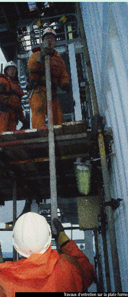
Travaux d'entretien sur la plate forme.
