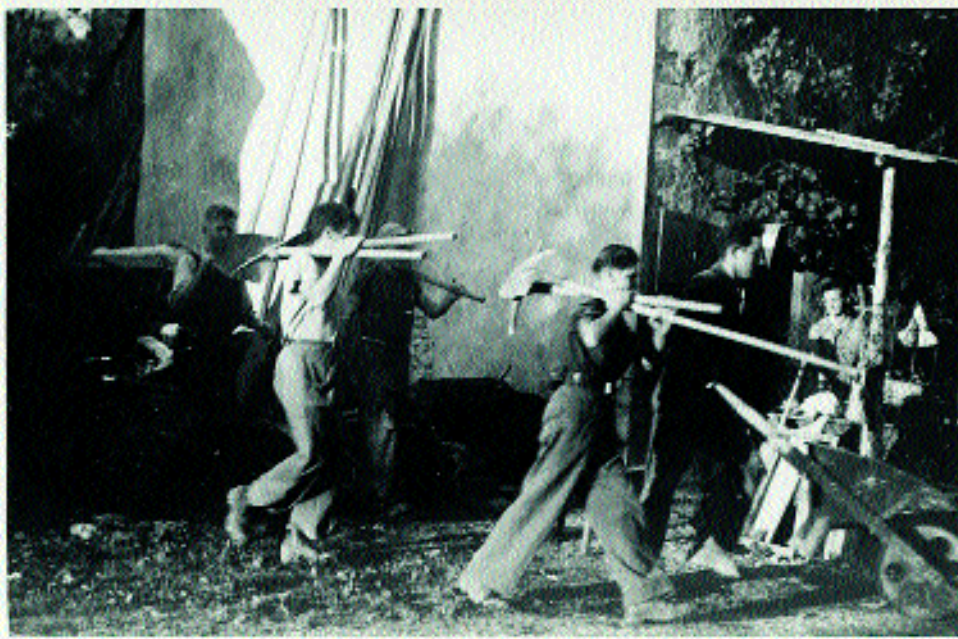
En 1945, des volontaires du Service civil international reconstruisent le village d'Ecurcey (France).
