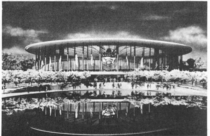
LE PAVILLON DES ETATS-UNIS sera le plus vaste édifice circulaire du monde. Construit en plastique, il sera doté d'un étonnant toit en forme de roue de bicyclette et d'un plafond suspendus.
