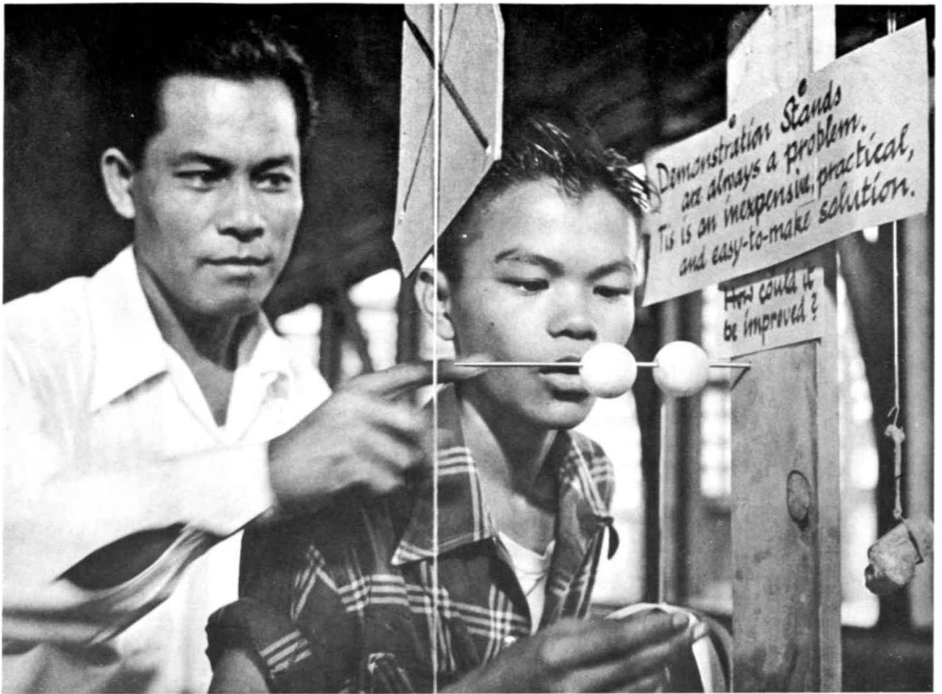
Pourquoi un avion vole-t-il ? Rien n'est plus simple que de répondre à cette question. Avec deux balles de ping-pong et une aiguille à tricoter, un professeur philippin démontre le principe de Bernoulli : soufflez sur les balles, elles se rejoignent, donc, dans un courant d'air, la force se déplace en direction du centre.
