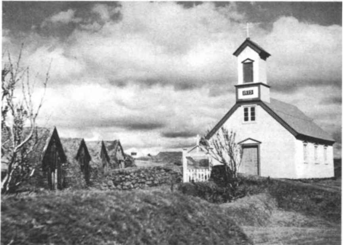
AUTANT DE TOITS QUE DE CHAMBRES La ferme traditionnelle islandaise est à moitié enfouie sous terre et comporte autant de toits qu'il y a de chambres. La succession de toits que l'on voit à gauche de cette photo représente une seule ferme, vestige précieusement conservé de l'architecture des Vikings, que l'on vient visiter comme un musée. L'église luthérienne représente le type parfait du temple de campagne.
