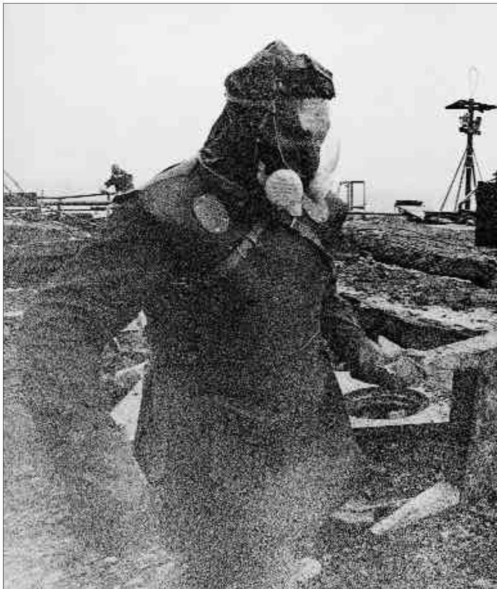
Au lendemain de l'explosion, 50 000 «liquidateurs» se relayent sur le toit du réacteur pour
