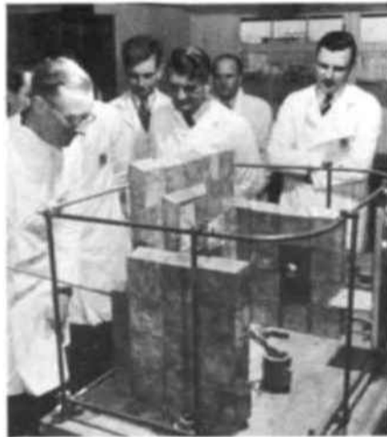
Au centre de recherches atomiques de Harwell (Grande-Bretagne) un mur de briques protège les opérateurs contre les radiations nocives dégagées au cours de manipulations d'éléments chimiques radioactifs. Pour placer des objets dans le creuset à isotopes (à droite) ou les retirer, on se sert par prudence de longues pinces.
