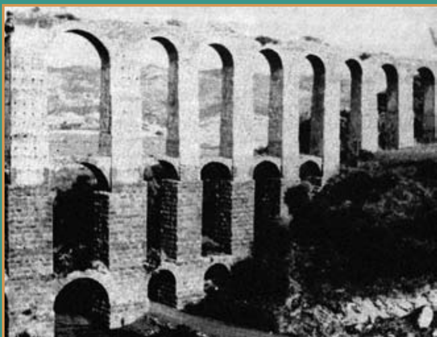
ACUEDUCTO DE CHERCELL — Argelia
