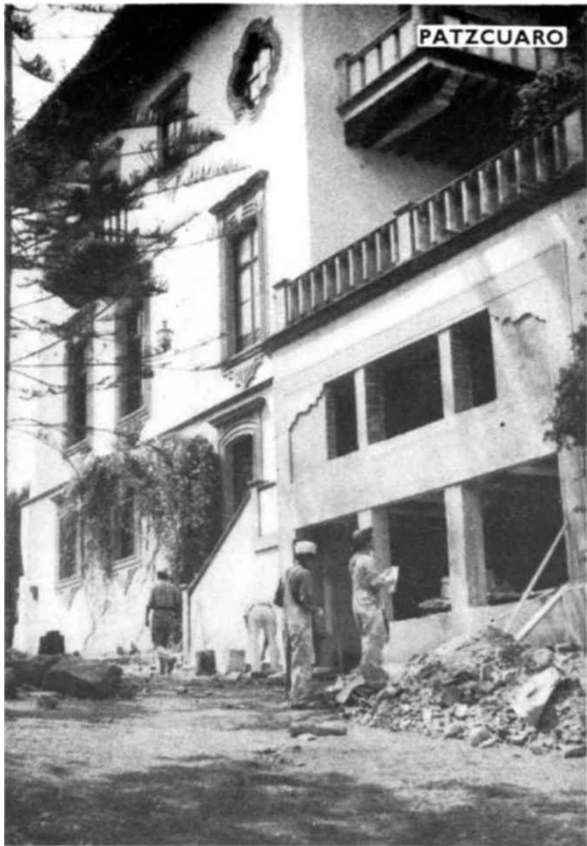
En « Eréndira », la villa ofrecida por el General Cárdenas, se han instalado las aulas de estudio y la administración del Centro. A fin de ganar algo más de espacio, los albañiles transforman el antiguo garaje en un edificio de dos pisos, donde funcionará una imprenta para libros de texto.
